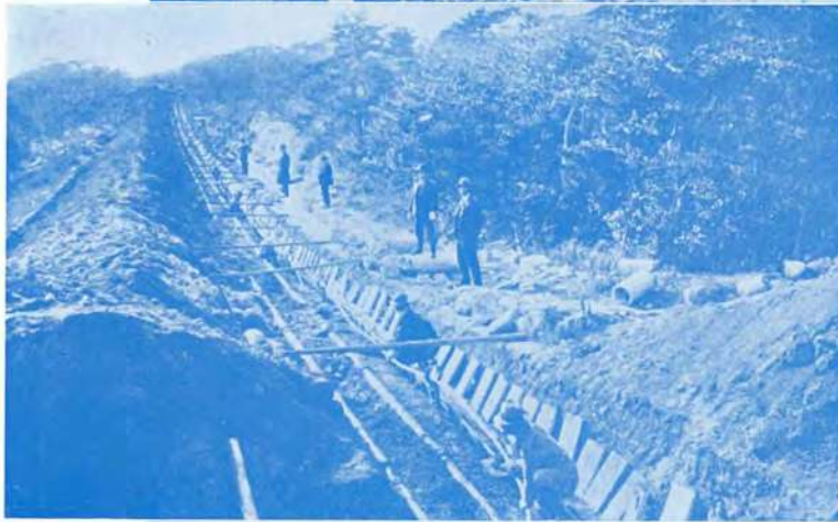
下水工事（ヒューム管埋設）
