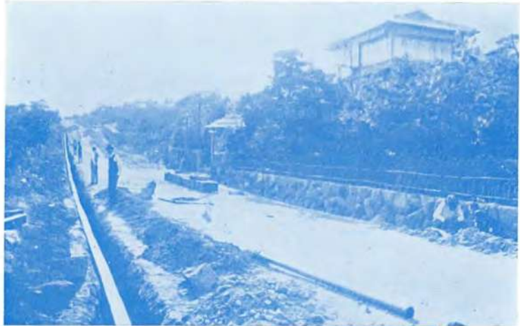
水道、瓦斯、電気地下埋設工事
