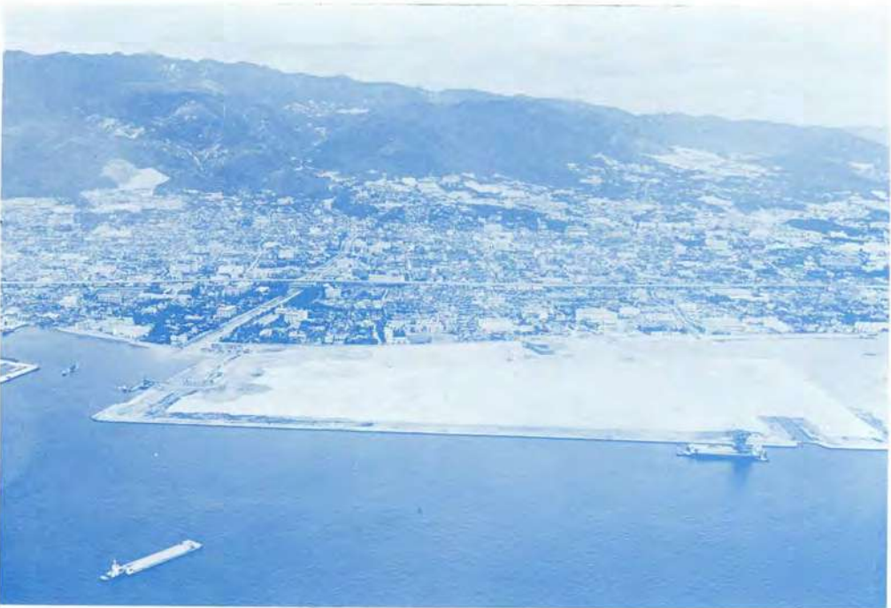
一部埋立てられた海岸地帯
